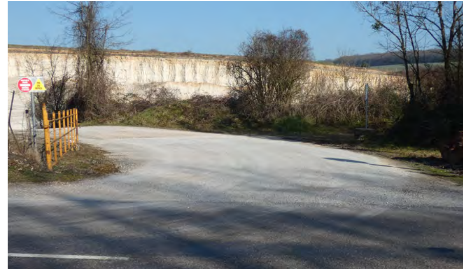
▲ La voie de sortie en matériaux stabilisés
